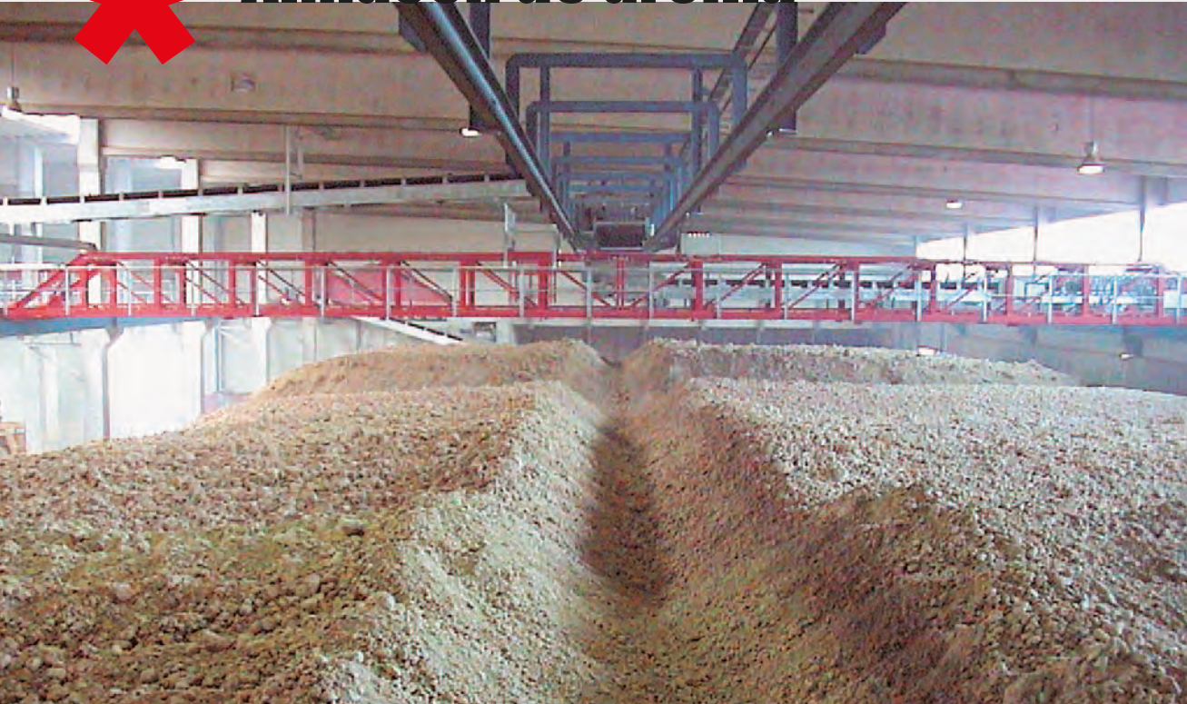
* Almacén con puente de carga
