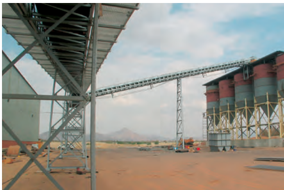
* Remplissage silo argile
