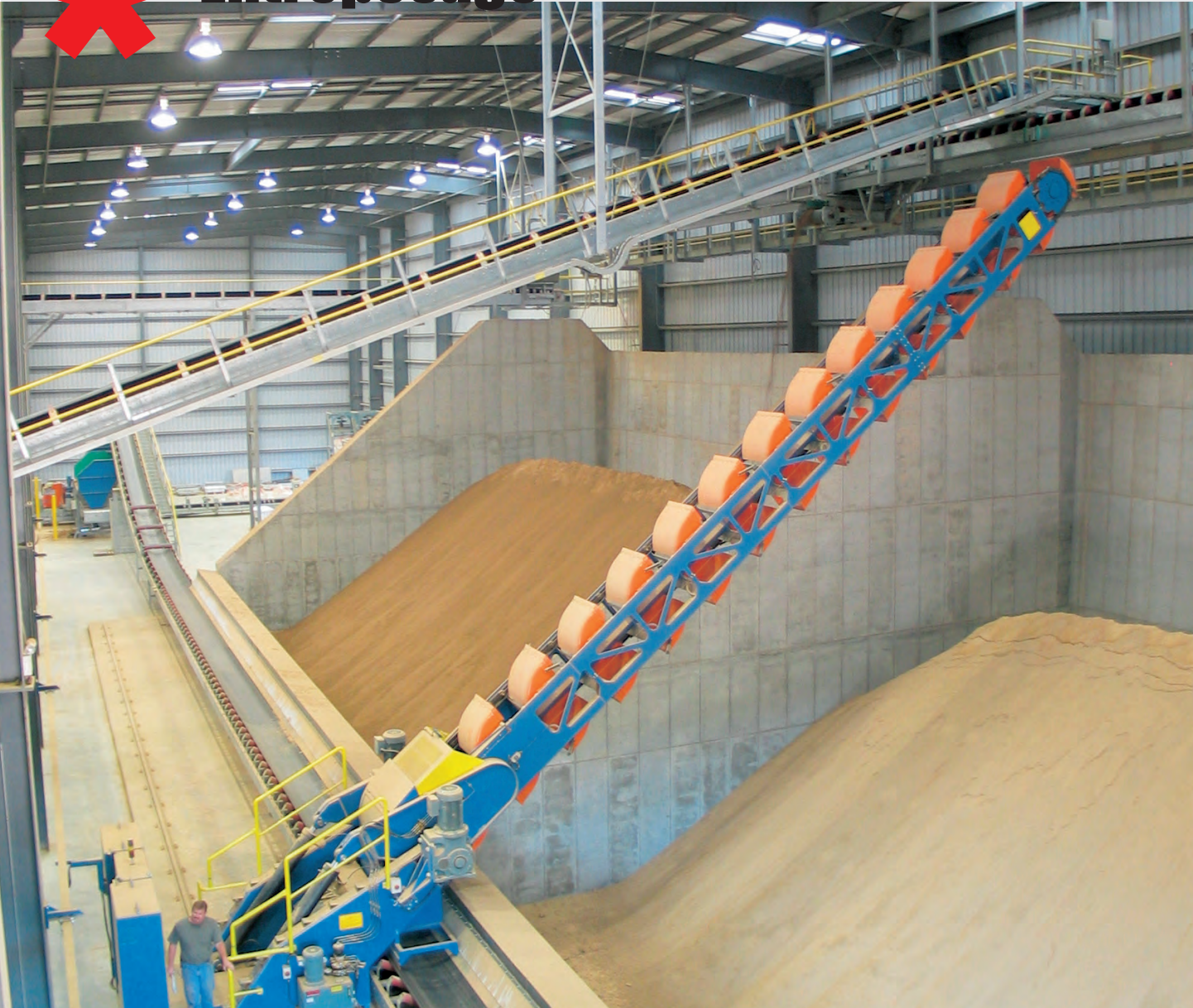
* Entreposage en ligne
