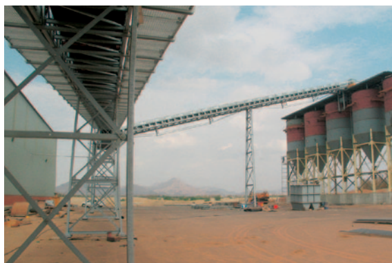
* Riempimento dei silo stoccaggio argilla
