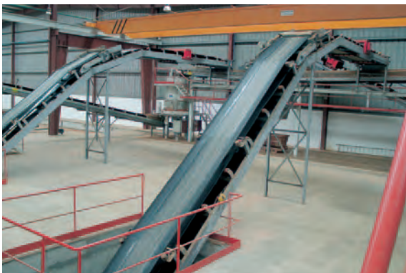
* カバーベルトコンベアによる廃棄材料搬送
