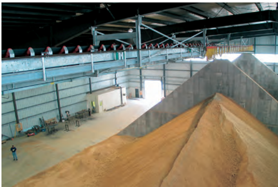
* Глинохранилище с передвижным и реверсивным ленточным транспортёром
