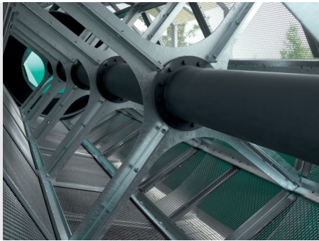
* 「ねじれ耐性に強い、傾いたスクリーン本体（内部図）」
